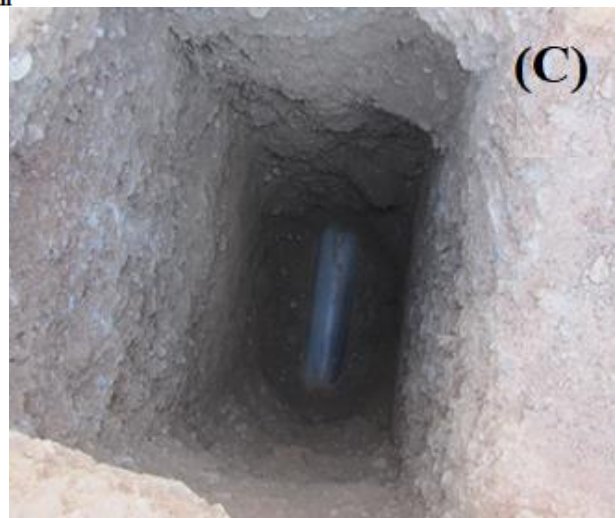
شکل (۱) طرحواره نحوه چرخش هوا (a)، دمنده هوا (b) و حفر چاهک جهت قراردادی دیتالاگر (c)
